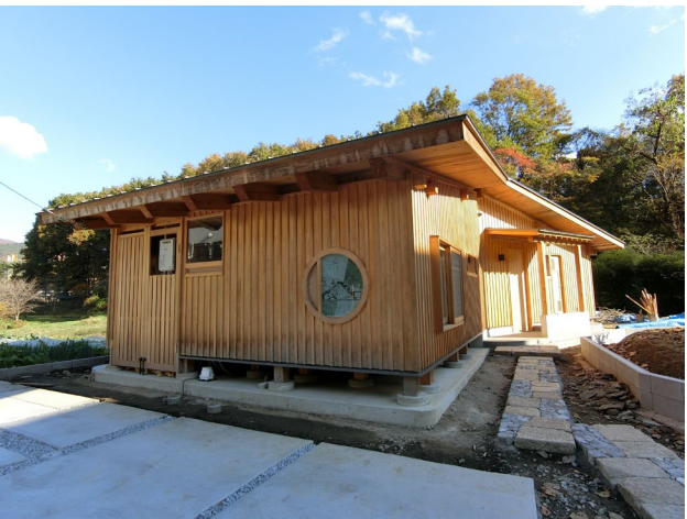
地元産の石灰を使った土間コンクリート
