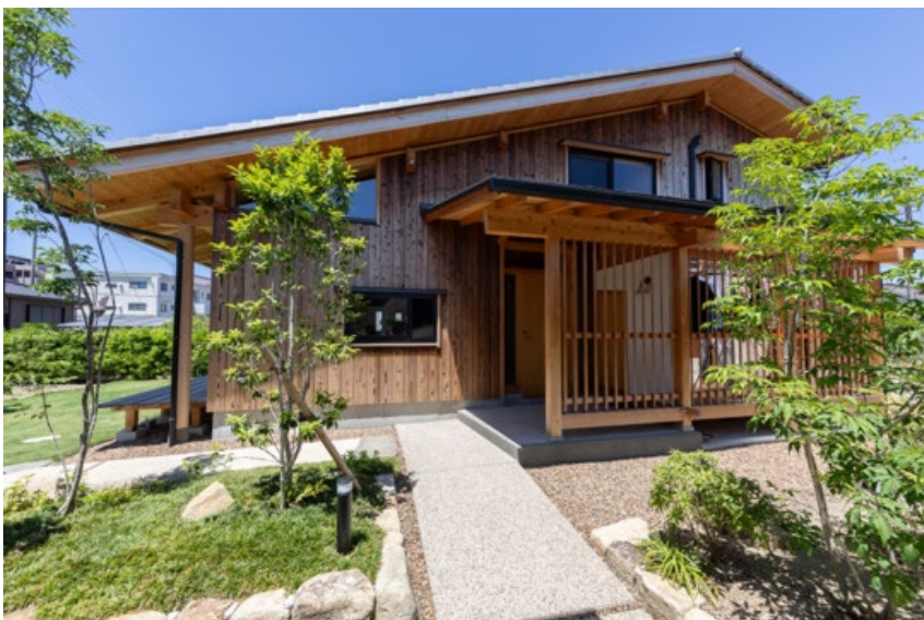
景観に馴染み、時間とともに趣が増す焼杉板の外観
