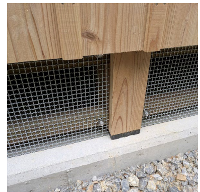
床下通気の季節に応じた制御 （冬は床下塞ぎ板の設置）
