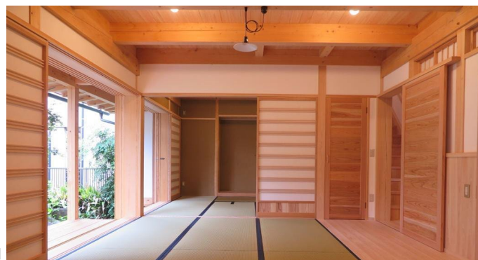
大きな窓や引戸、欄間によって 通風を確保する室内空間
