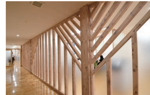
木製ルーバーを用いた2階内部通路
